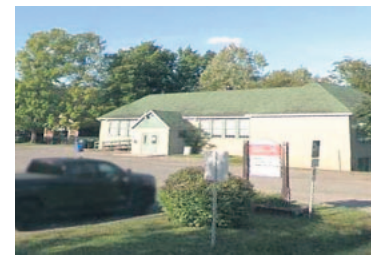
Le 21 août 2023, le conseil municipal adopte une résolution décrétant la fermeture et la désaffectation du bâtiment du Centre culturel et communautaire de Prévost en raison de sa vétusté.
