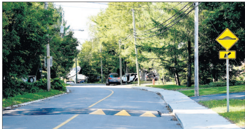
À Prévost, un dos-d'âne nouvellement installé sur la rue Principale a été l'objet de critiques par des automobilistes surpris, car les couleurs n'avaient pas encore été peintes sur cette butte bétonnée. Les couleurs furent ajoutées dans les deux jours qui ont suivi avec des panneaux indicateurs
