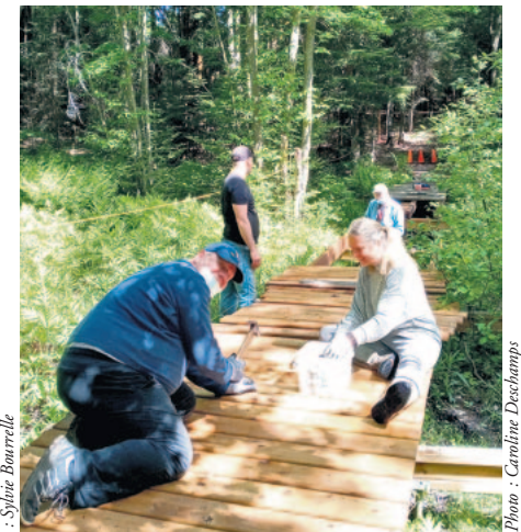
Élargissement de la passerelle pour faciliter le passage de la dameuse de sentier de ski de fond
