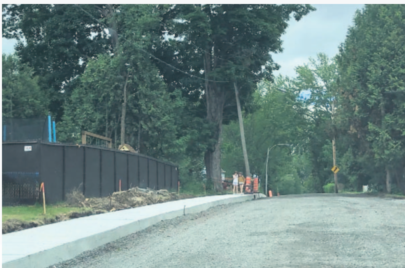
Nous avons construit des trottoirs comme jamais cela a été fait à Prévost, particulièrement dans le vieux Shawbridge – photo : Paul Germain
