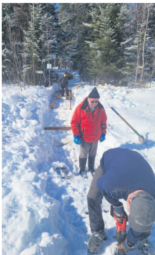
Les travaux ont commencé par le démontage de l'ancienne passerelle. André et Fernand fixent un 4 X 4 qui servira d'appui sur les pilotis et Jean-Marc installe les bases du futur tablier.
