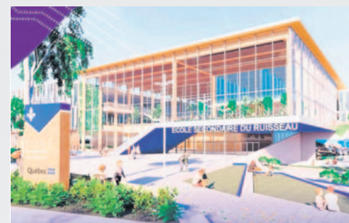
Le ministère de l'Éducation a entrepris de donner une nouvelle facture visuelle aux prochains projets d'écoles
