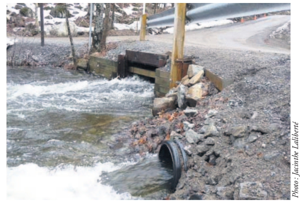
Au printemps ou lors de pluies torrentielles, le barrage du lac Ouimet ne pouvait contrôler le débit d'eau d'où les nombreuses fluctuations du niveau de l'eau. La Municipalité de Sainte-Anne-des-Lacs procédera à des travaux à l'exutoire du lac Ouimet, en 2022, puisqu'il ne répond pas aux besoins hydriques du lac et du secteur.
