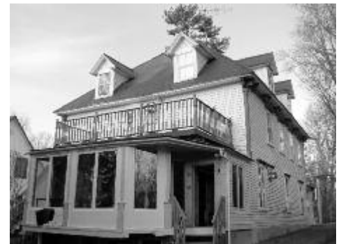
La seule variante avec les modèles habituels: le nombre de lucarnes. Les plans traditionnels en comptent une en façade, celle-ci en a sept réparties sur tous les pans!
