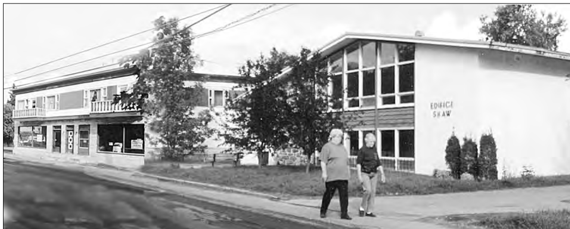
D'ici la fin de l'automne, l'édifice Bastien et l'édifice Shaw seront rénovés afin d'y aménager 12 nouveaux logements.
